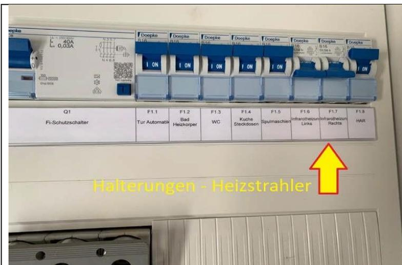
Um diese einzuschalten, müssen zuvor im Durchgang die Sicherungen **Heizstrahler rechts/links** eingeschaltet werden.
